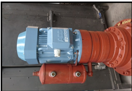
Fig. 11. Sustitución Motor Eléctrico.
